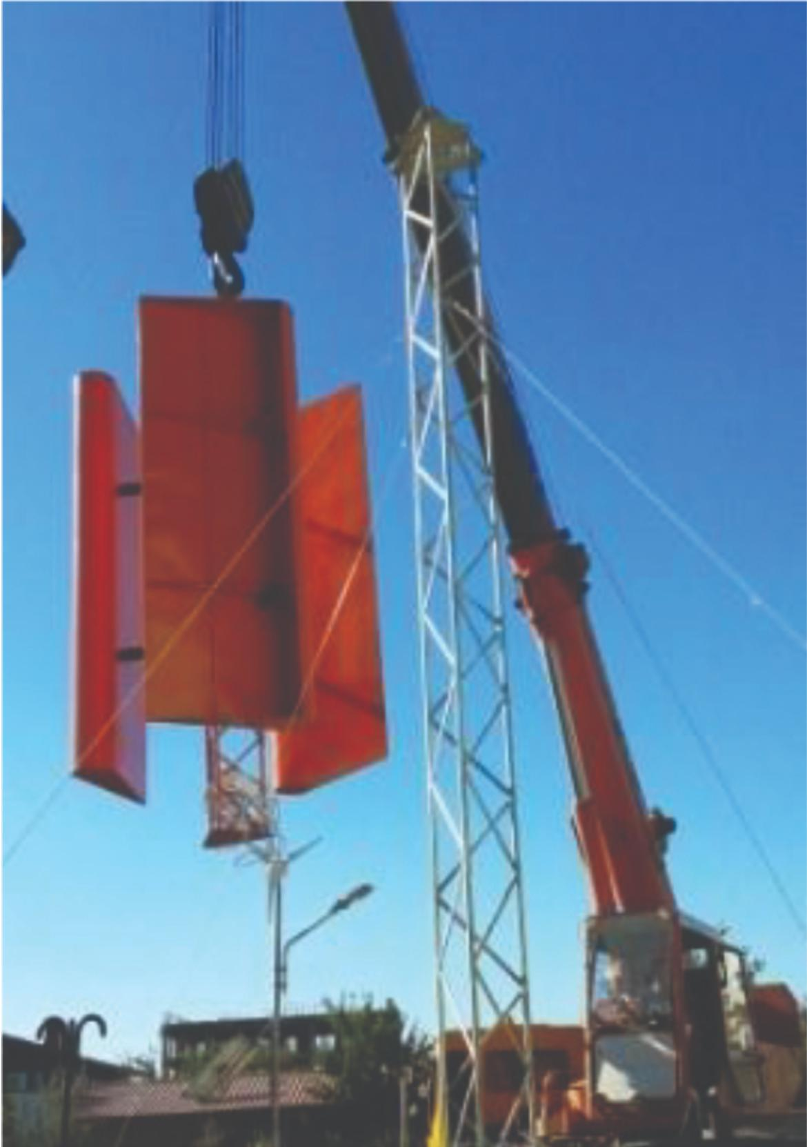
Figura 13: Gru che solleva la parte superiore della turbina eolica.
